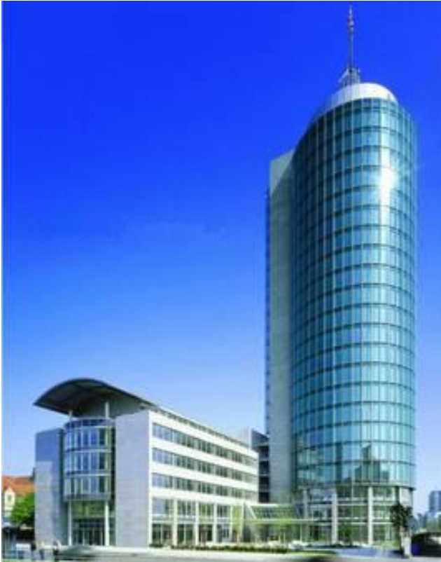
Abb. 8: Munich City Tower: Betonvolumen: 110.000 m 3 ; Bauzeit: 8/2001 - 1/2003:
